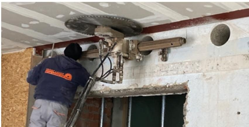
Mit der beeindruckenden Wandkreissäge wurde der Durchgang zwischen Alt- und Neubau geschaffen.
